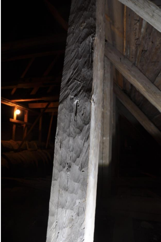
Virket är slinthusget, ofta med tydliga drag av sprättthuggning.
