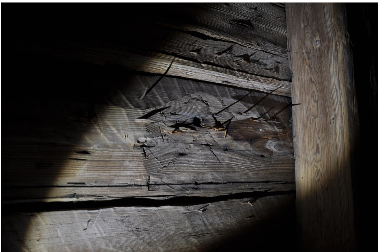
Ett stort antal tidigmedeltida brädor finns bevarade. Mitt i bild kan man se att ytan justerhuggits för att brädan skulle ligga bra an mot sparran i sin tidigare konstruktion, samt ett borrhål för en tränagel.
