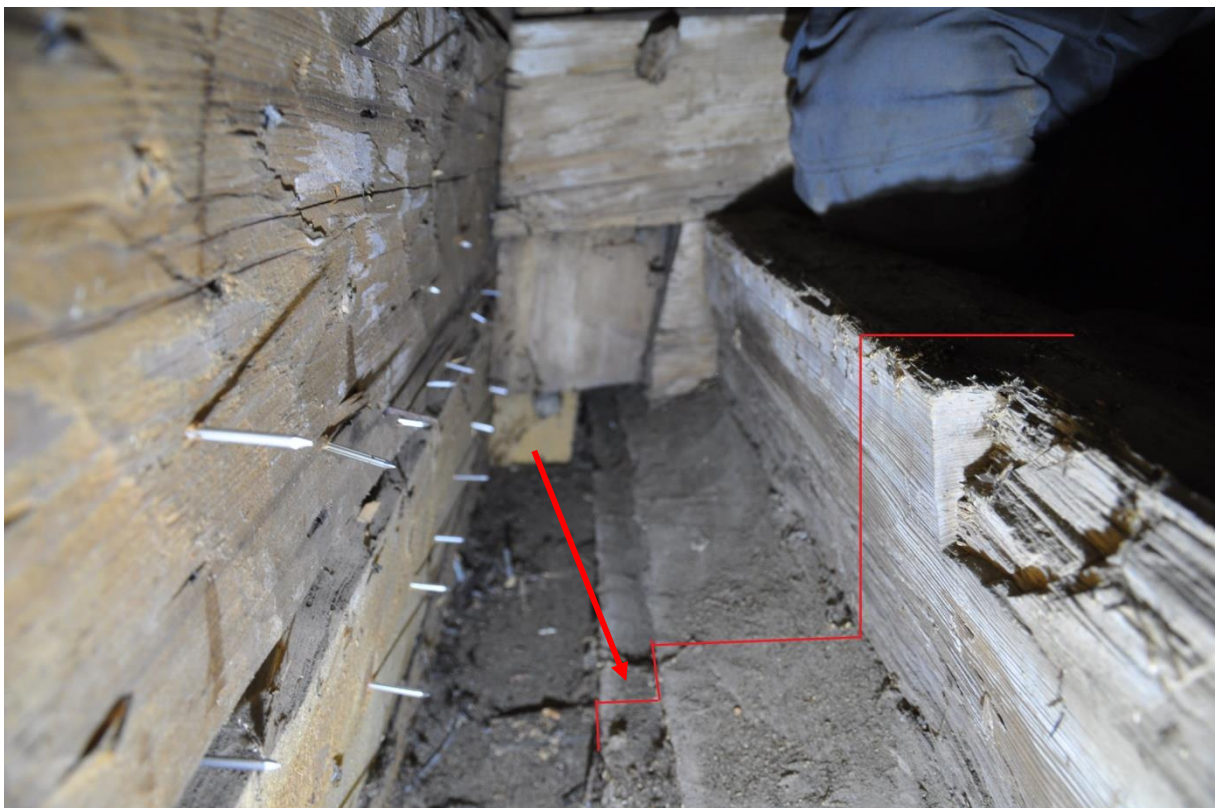
Den ursprungliga syllramens utsida, huggen ur en och samma stock. Den nedre falsen har troligen utgjort det inre upplaget för en takfotsbräda.
