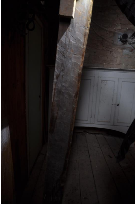
Troligen tidigmedeltida bräda. Nu använd som stöd för en modern landgång! Förborrade spikhål som märkts ut med ritsar .
