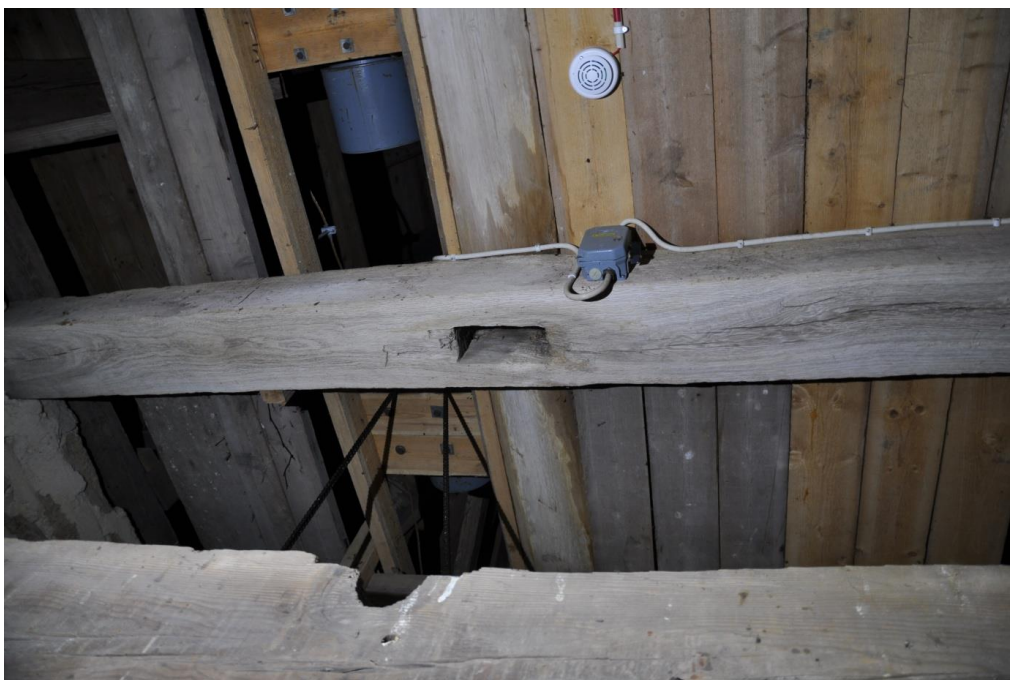
Den mittre av de tre ursprungliga bjälkarna som ingått i den första tornhuvens konstruktion. I mitten syns ett tapphål där tornhuvens hjärtstock tidigare stått.
