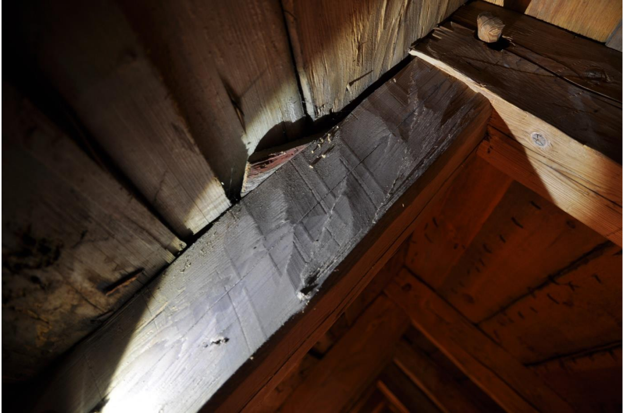
Virket är skrätt nästan vinkelrätt mot fibrerna.
