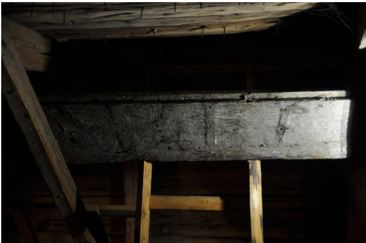
Uppe på hanbjälkarna finns en bräda fastspikad. Förmodligen från ett mycket gammalt dörrblad.
