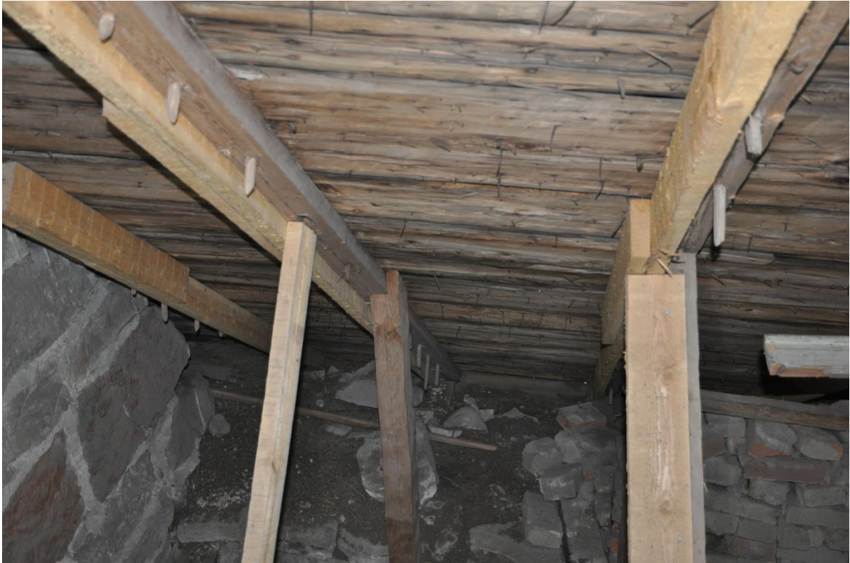
Undertaket består till största delen av brädor som är framställda genom klyvning och behugning. De är fästa mot högbenen med genomgående tränaglar.
