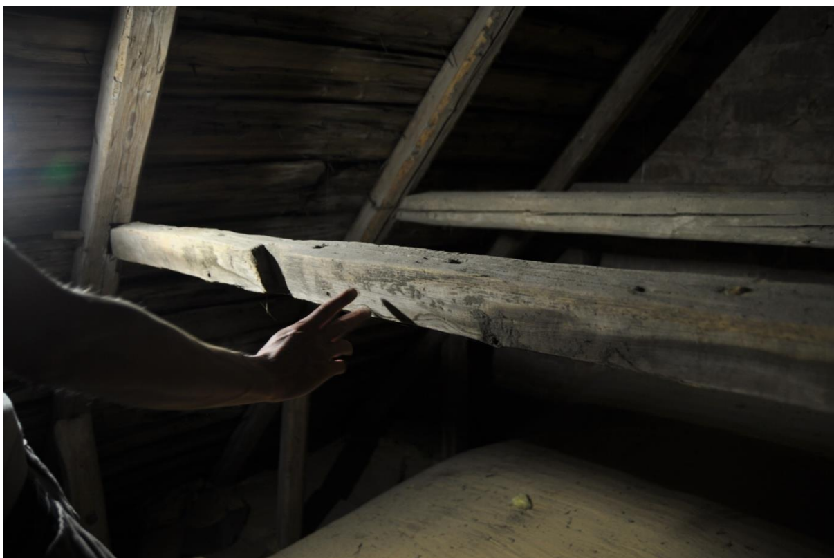
Hanbjälke av återvänt virke i sakristian. Kanske ett högben från det ursprungliga koret. Lägg märke till raden av borrhål på oversidan. Det kan vara från korets undertaksbrädor som suttit fastdymlade där.
