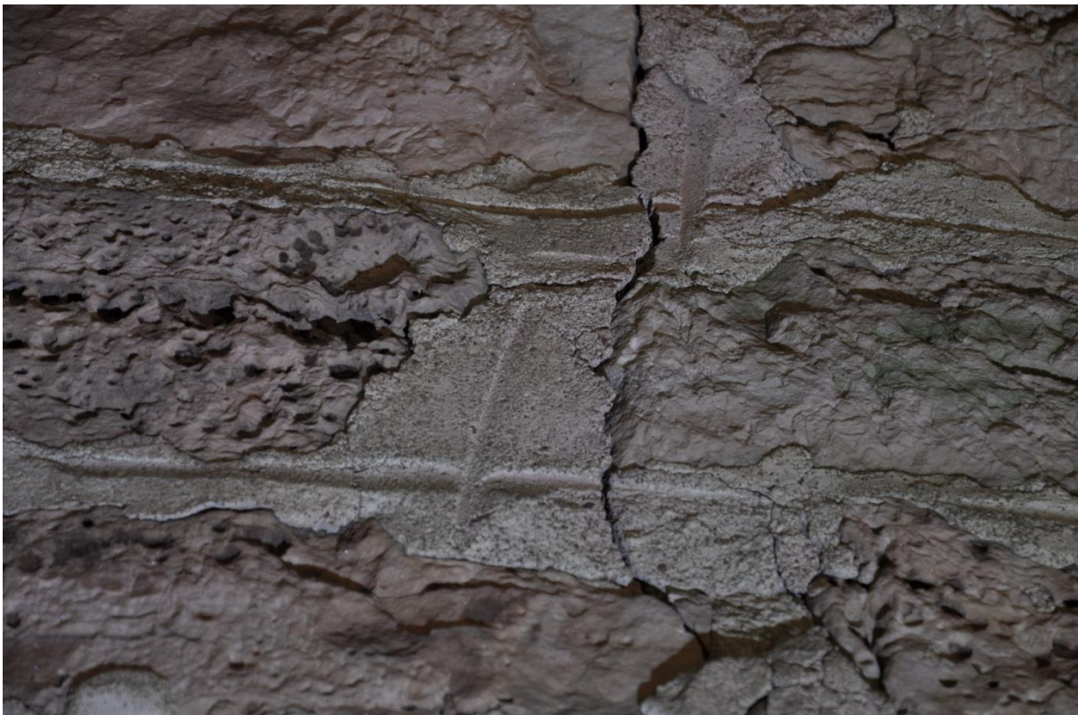
Ritsade fogar i tornets murverk.
