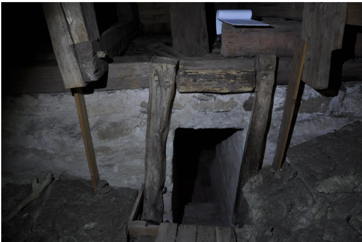
Öppningen mellan långhus och sakristia. Lägga märke till dörrromfattningen. Inne i öppningens tak sitter en romansk stenrelief.
