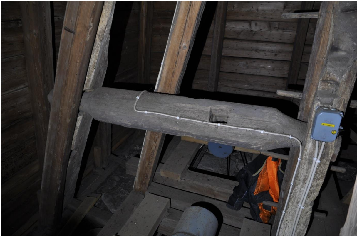
Hissanordning för kyrkklockorna. Rullen sitter i ändarna fast med återanvänt sprätthugget virke.
