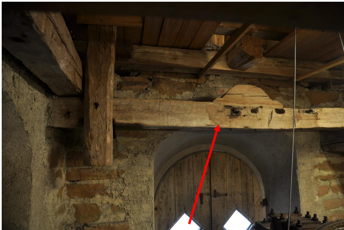
Bilden visar en av två bevarade bjälkar för klockupphängning.
