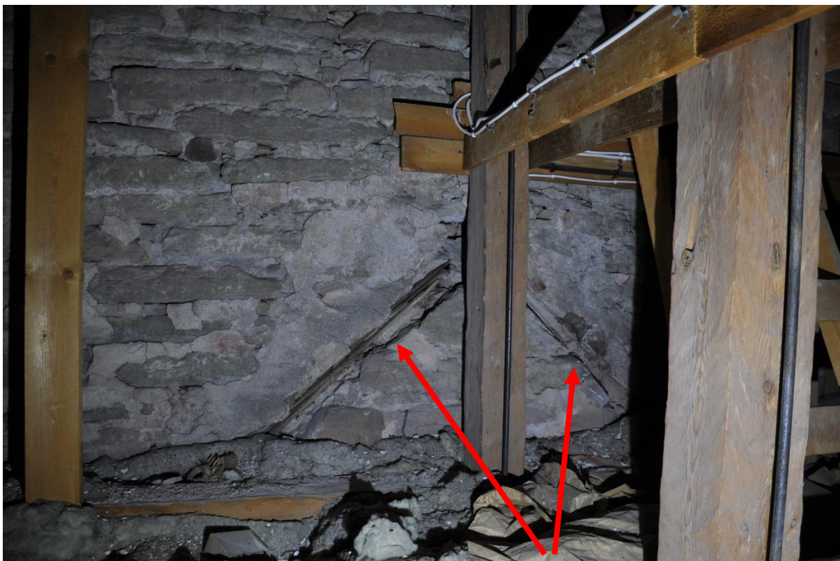
Det äldre långhustakets anslutning mot tornet. Sex troligen medeltida takspån sitter här inmurade.
