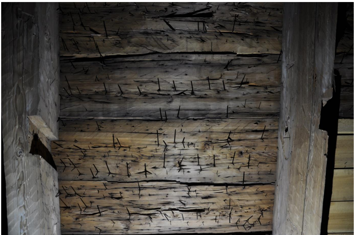
Stora delar av undertaket är ursprungligt. Lägg märke till de tomma urtagen för de bortplockade hanbjälkarna.
