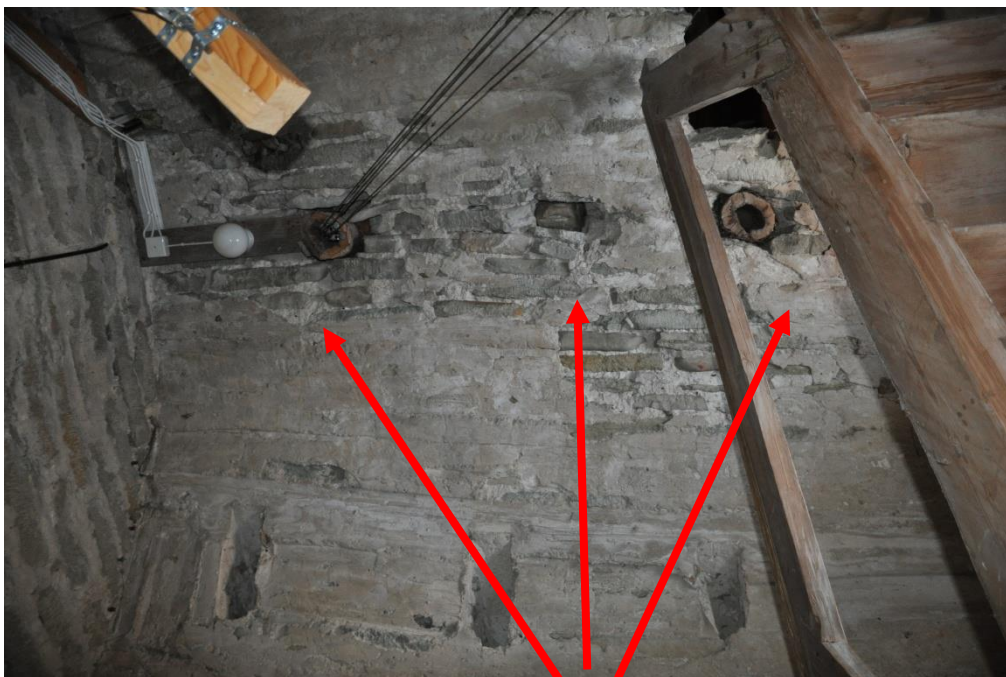
Genomföringar för klockringningsrep i tornvåningens valv. Möjligen har där varit tre stycken.
