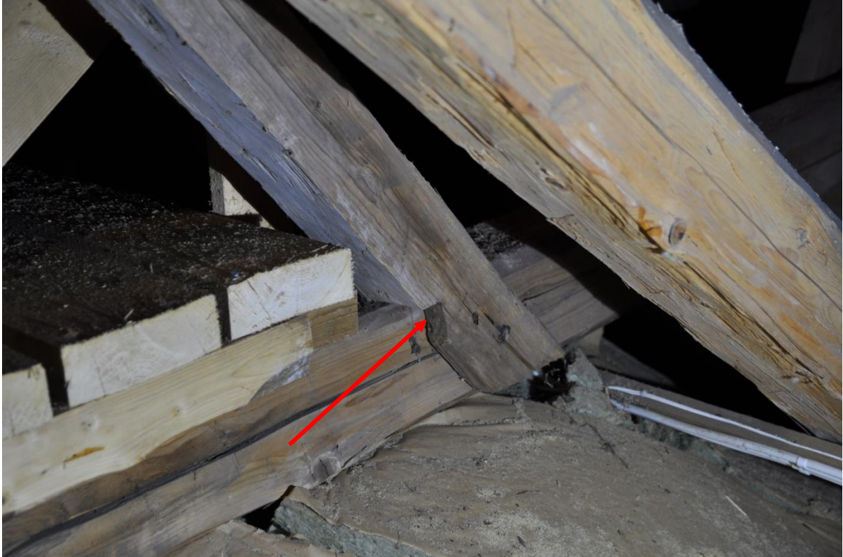
Här ses ett återanvänt stödben som står med en bladning på en horisontell bjälke. Tidigare har den suttit bladad halvt i halvt i en knutpunkt med nacke...
