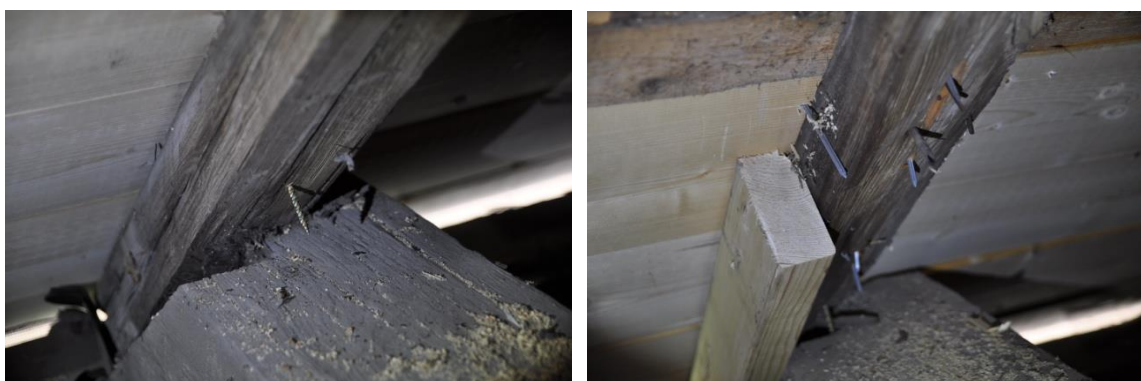
Mycket ovarsamma lagningar med alldeles för långa spik och skruv.
