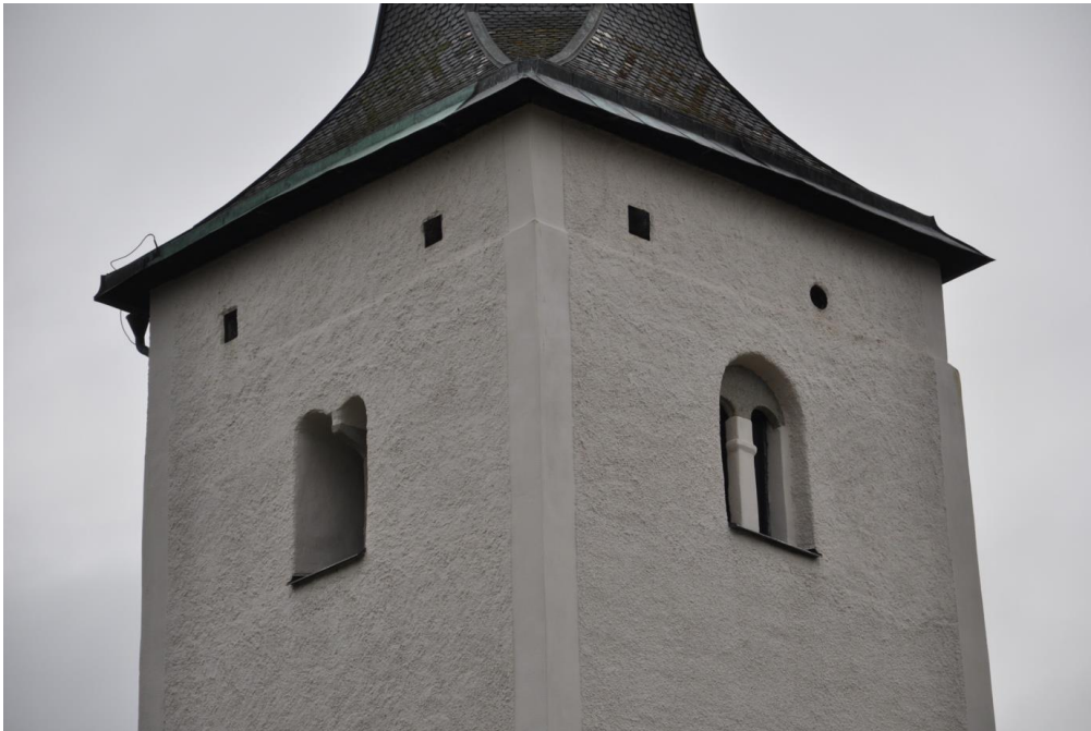
Mindre öppningar under takfoten. Fem fyrkantiga och tre runda.
