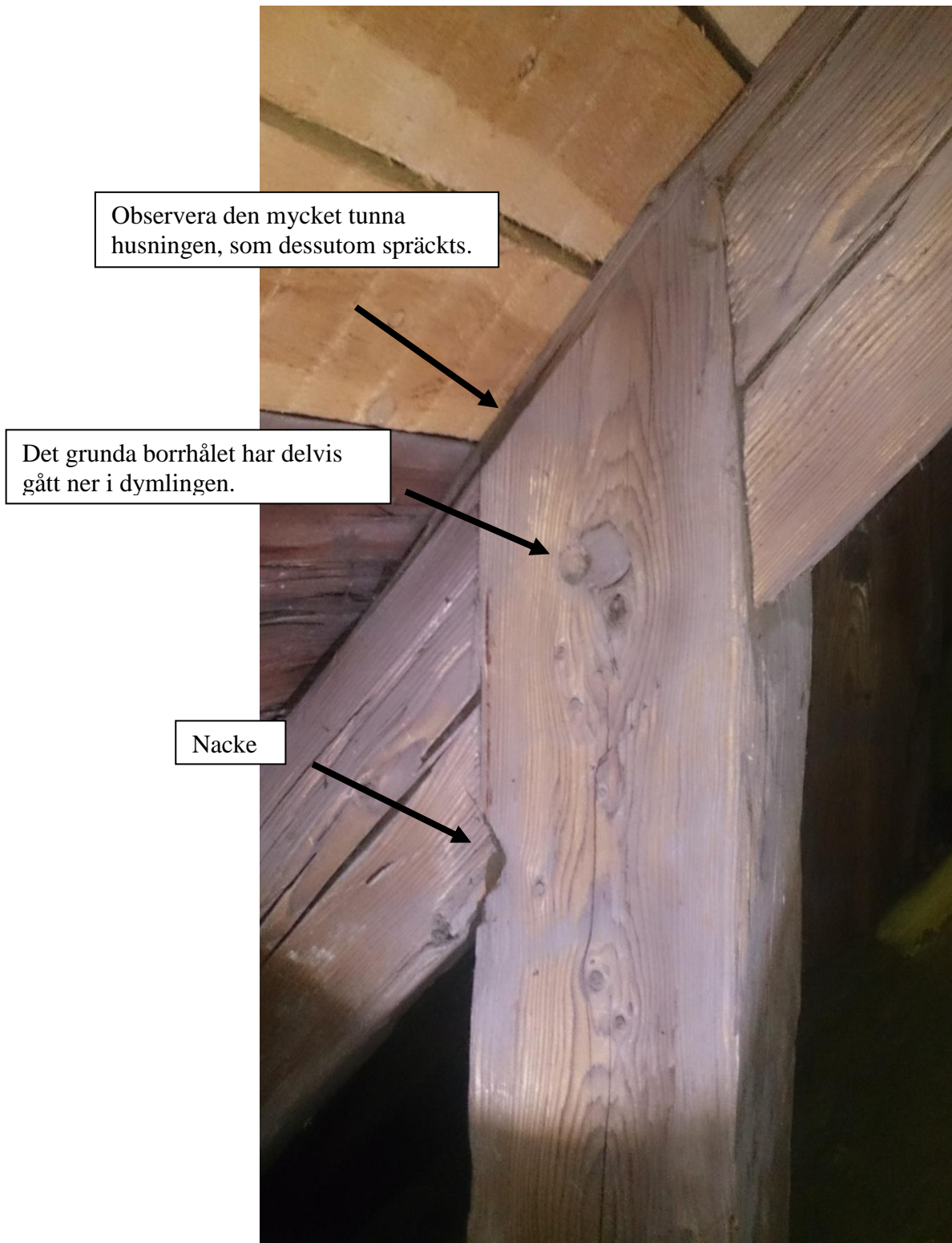
Stödbenets anslutning mot högbenet. Husad knut med nacke. Observera det grunda borrhålet som uppstått vid genomborring av knutpunkten på den ovanliggande takstolen.
