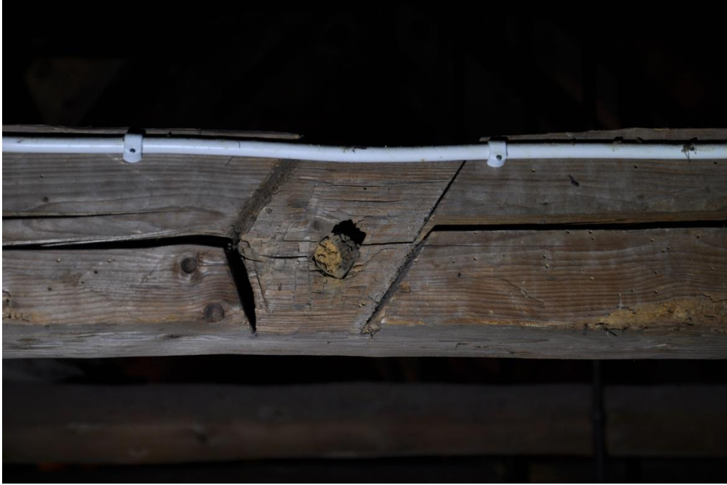
Knutpunkt med nacke. Dymlingen sitter fortfarande kvar.
