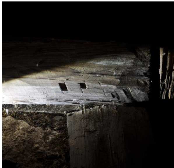
Två olika typer av timmermansmärkning.
