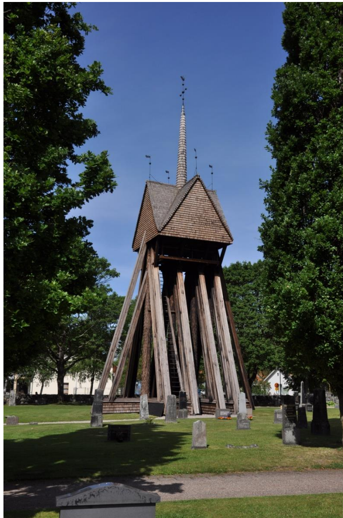
Klockstapel av typen öppen klockbock, med korsande sadeltak.
