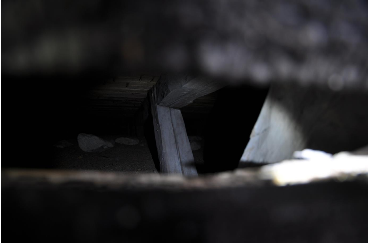
Bilden som är tagen utifrån genom en rötskada i remstycket visar en takstol med knäbock.
