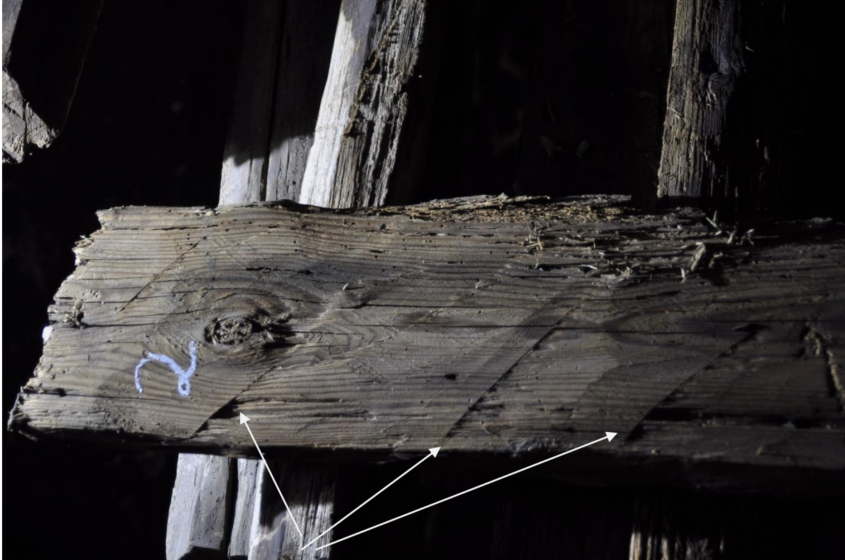
Många bitar har diagonala upplättningshugg. Detta görs, om man vid finhuggningen har ganska mycket ved kvar att hugga bort, för att underlätta avverkningen.
