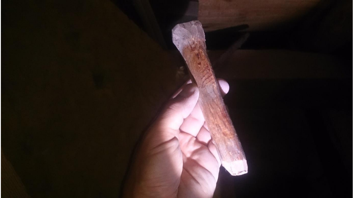
Välgjord dymling med markant ansvällning i ena änden. Lösfynd på norra murremmen.
