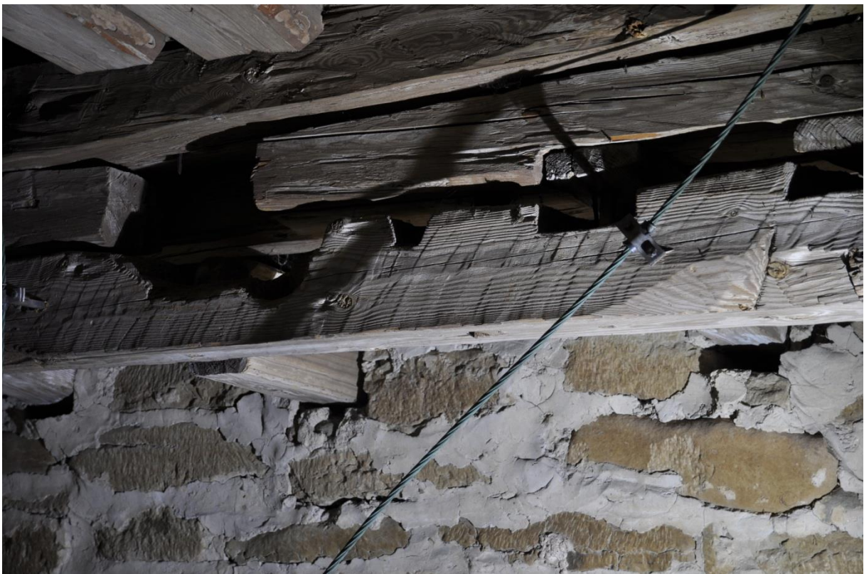
Sprätthuggning på den nedre bjälken.
