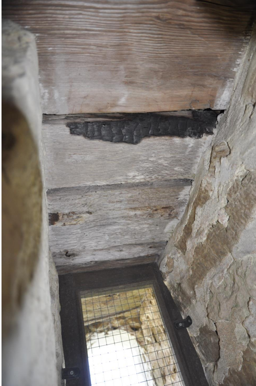
Brandskadat virke i ljudöppningarna.
