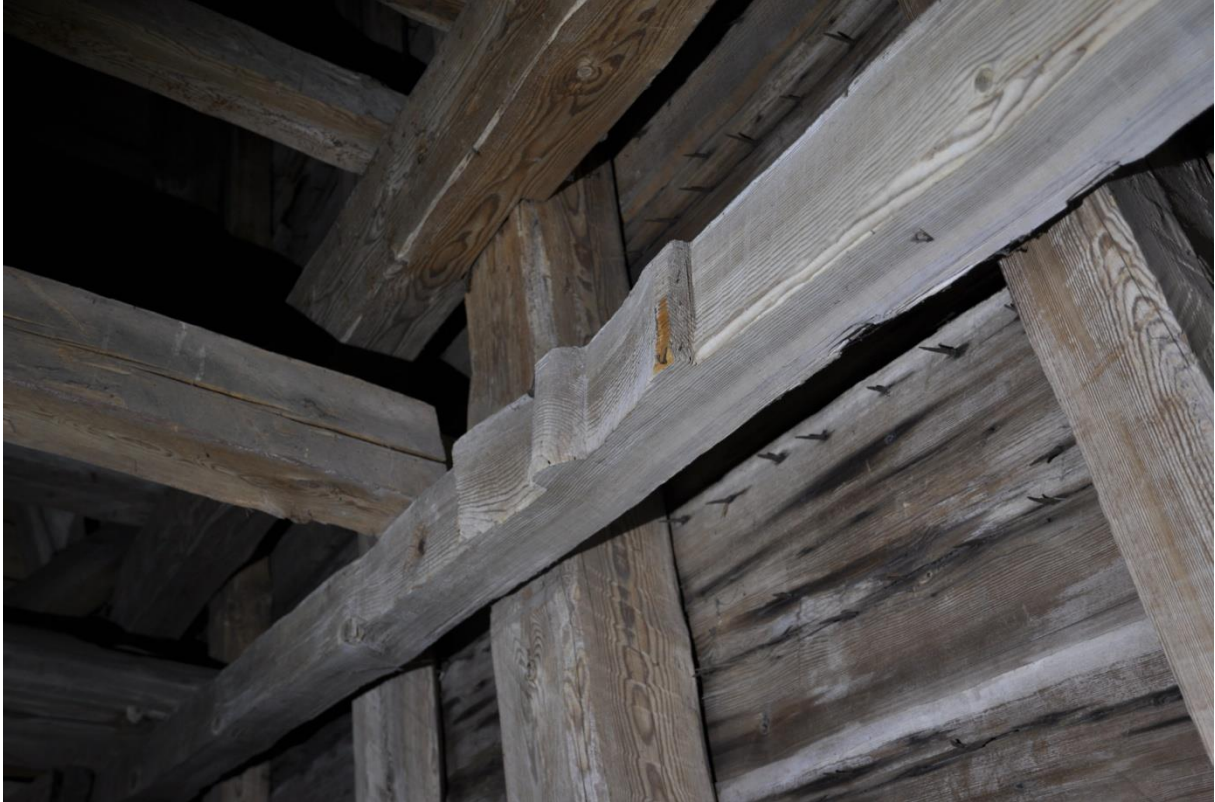
Ett av ramverkets hammarband.
