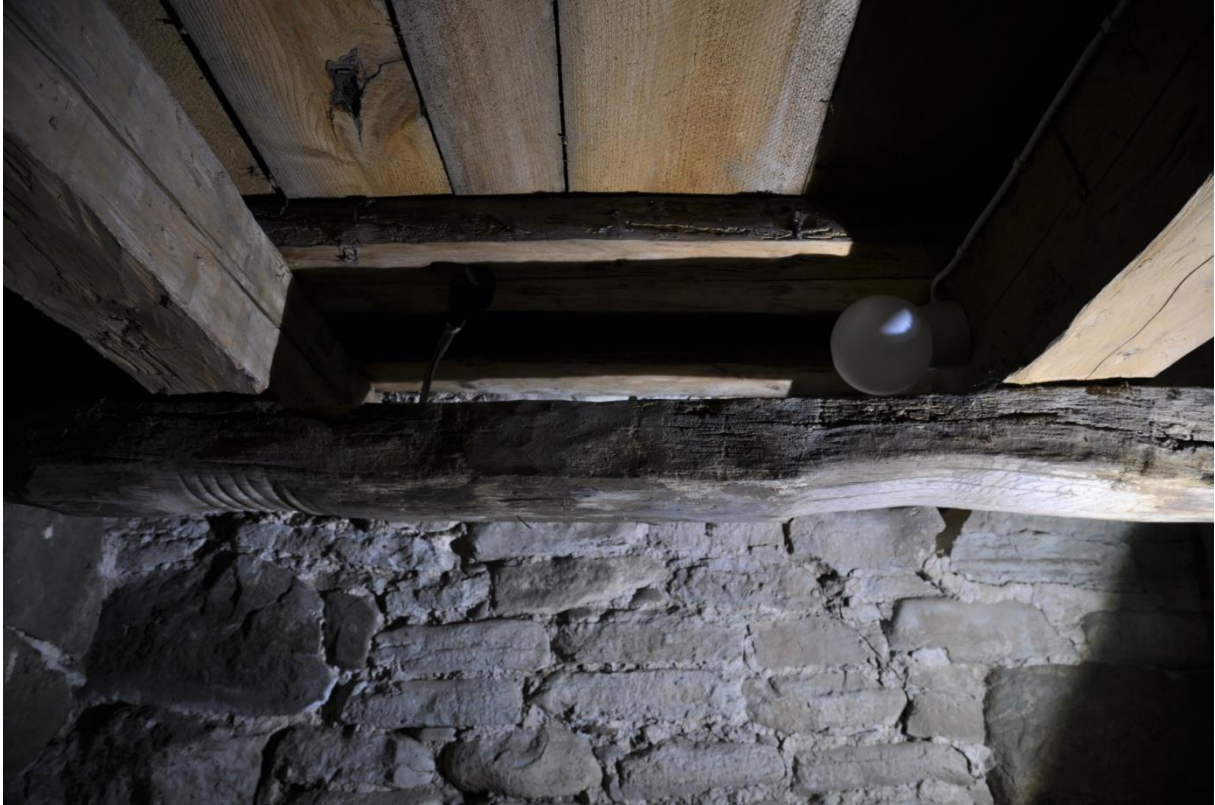
Återanvänd ekbjälke med tydligt slitage på undersidan.
