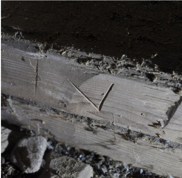
Två olika typer av timmermansmärkning.
