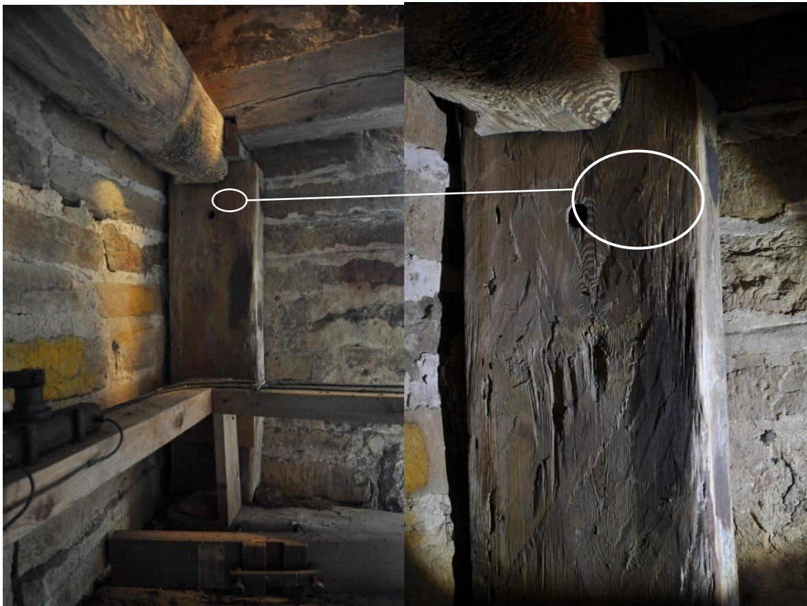
Den ena av de två stolparna som består av återanvänt virke. De uppvisar en variant av sprätthuggning (slinthuggning) samt en dimension som för tankarna till medeltida klocktorn.
