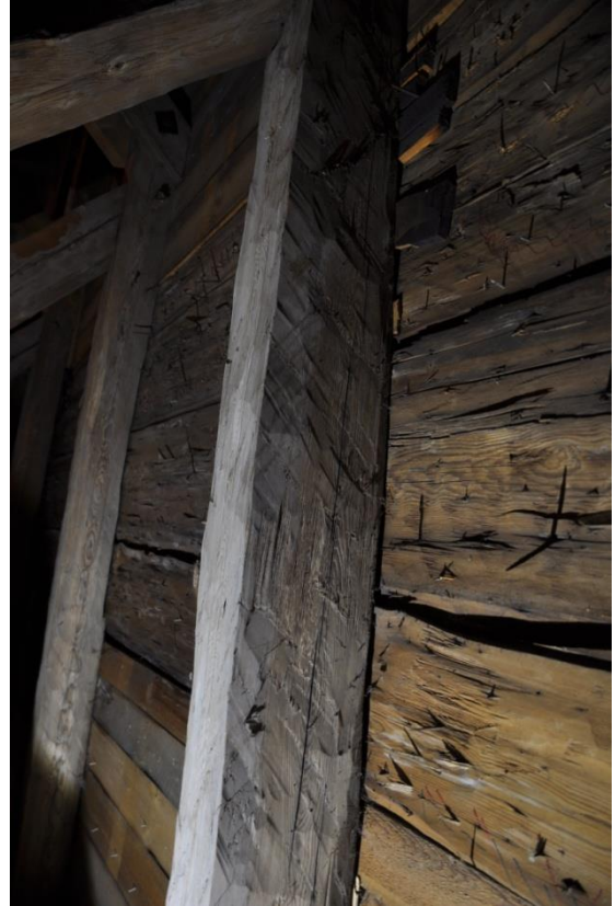
Virket är slinthusget, ofta med tydliga drag av sprättthuggning.
