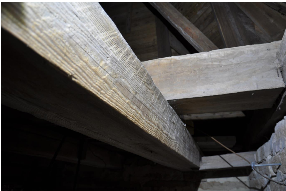
Bjälke i furu med tydliga spår av medeltida sprätthuggning. Längst bort syns en av stickbjälkarna.
