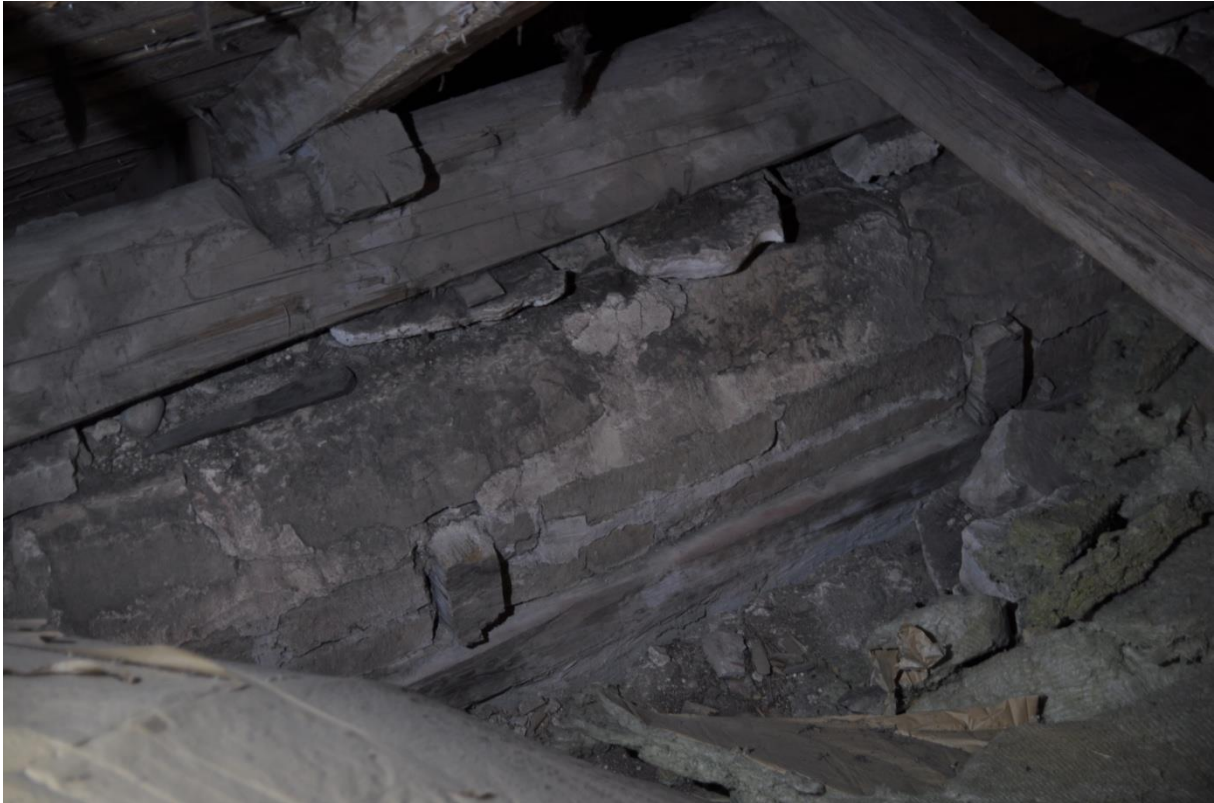
När isoleringen plockades bort frilades delar av det allra äldsta taklaget. På nedre delen av bilden syns ett inre remstycke samt två avhuggna bindbjälkar.
