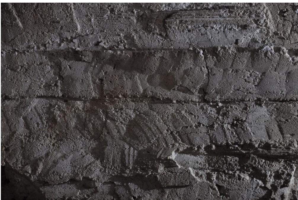
Avtryck i bruket från sprätthuggna brädor i tornets valv.
