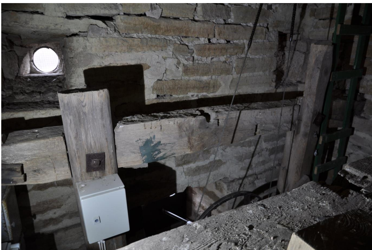
Gammal ekbjälke som i mitten har urtag för en tidigare klockupphängning. Uppe till vänster syns en av de små öppningarna i tornmuren.
