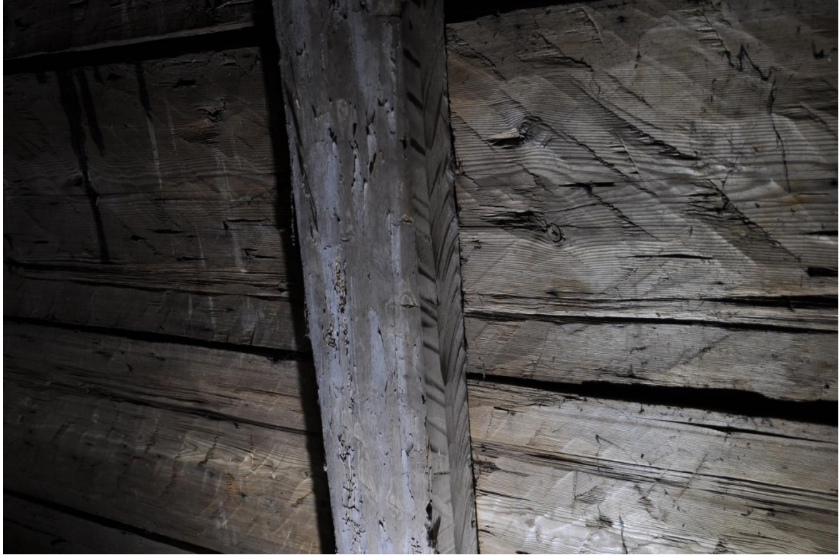
En av de trapetsformade sparrarna i tornhuven. Den är fint sprätthuggen på tre sidor, den fjärde sidan som vetter in mot rummet är helt obearbetad. Det sitter till och med tunna barkrester kvar. Troligen är de framkluvna som åttondelsklovor.
