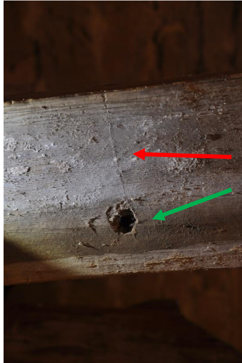
Troligen tidigmedeltida bräda. Nu använd som stöd för en modern landgång! Förborrade spikhål som märkts ut med ritsar .
