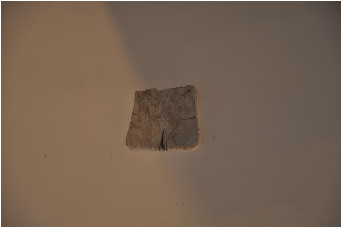
Avkapad bjälke, synlig i långhusets södra vägg.
