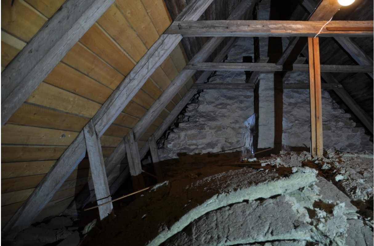
Sakristians taklag med snedställda stödben. Här syns också knutpunkter i samma utförande som i långhuset.
