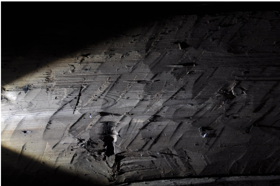
Sprätthuggen taktro. Mycket viktigt att bevara vid kommande takomläggningar.
