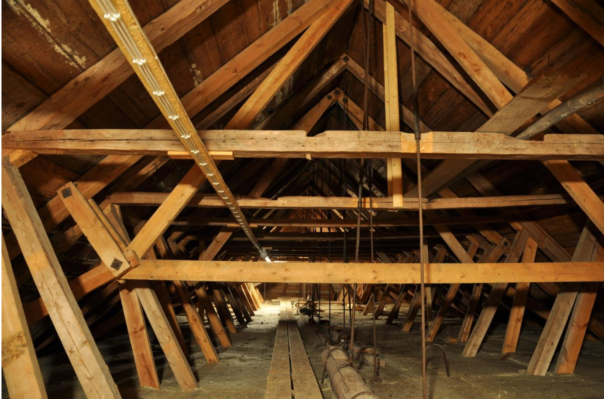
Ett 1700-talstaklag med många sentida förstärkningar. Ett återvänt högben sitter nu som övre hanbjälke, närmast i bild.
