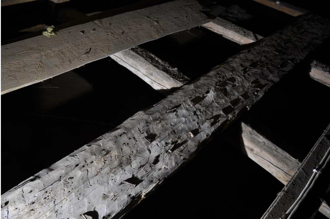
Tidigmedeltida yttertaksbräda med markant sprätthugning, gjord med en liten kortegged yxa. Ett stort antal spik från yttertaksstäckningen finns kvar.
