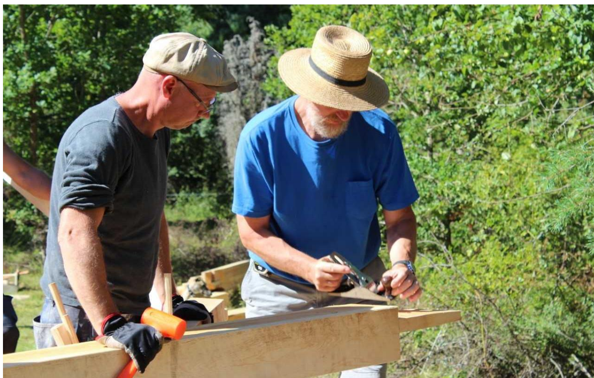
Jack demonstrerar så kallad "tapering" av tapp för smidig sammanfogning.
