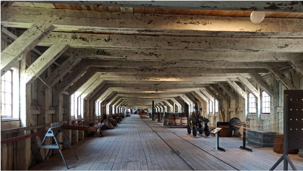
Bild inifrån Repslagarbanan. Konstruktionen är fortfarande intakt utan större förändringar.
